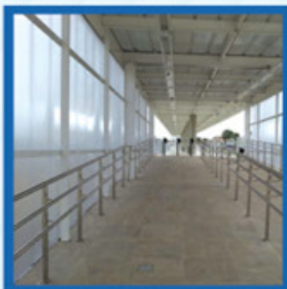
Aplicação de fechamento vertical
